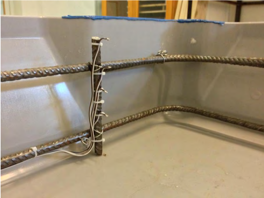
Figur 2.11 Termoelement placerade på armering invid plattans kant för registrering av betongens temperatur på fyra olika djup under härdningsförloppet.
