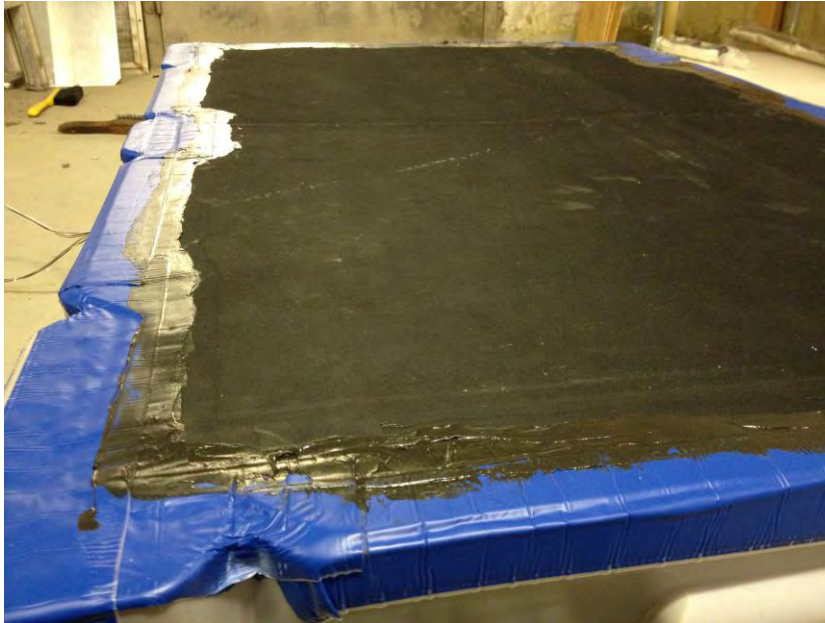
Figur 2.8 Betongplatta belagd med 2 mm butylduk och anslutning mellan butylduk och gjutform förseglad med butyltejp samt tätningsmassa av butyl.
