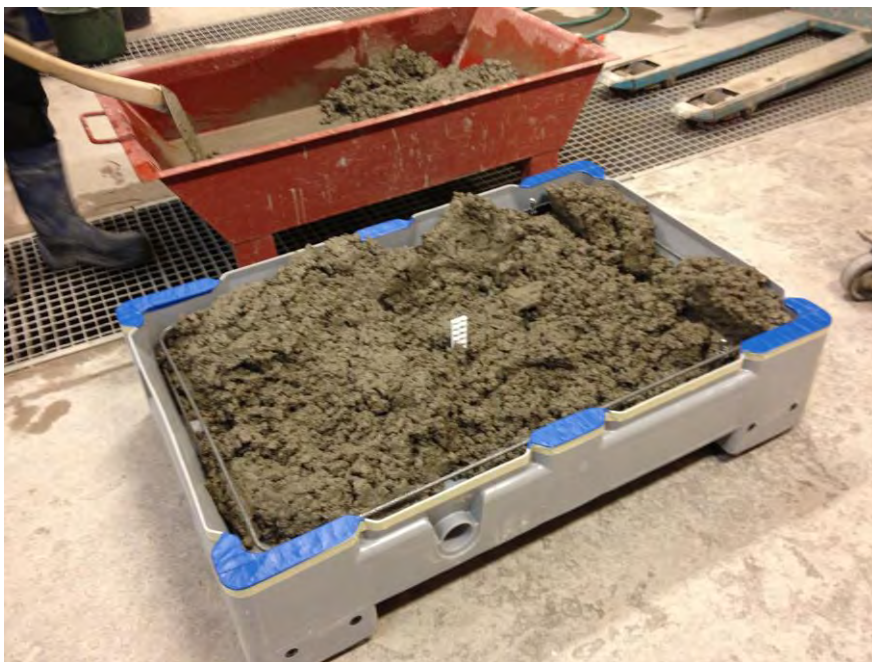
Figur 2.4 Gjutning med trögflytande konsistens i två skikt med mellanliggande bearbetning med stavvibrator.
